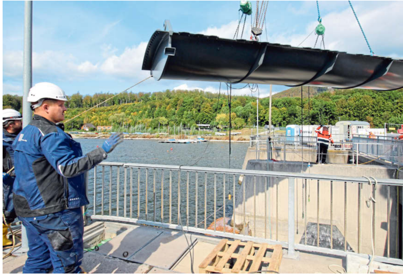
Der schwere Stahlkoloss wird per Kran an Ort und Stelle gehievt. Ihn sozusagen an der Leine in die richtige Position jenseits der Dammsperre zu fädeln, ist eine knifflige Angelegenheit.
